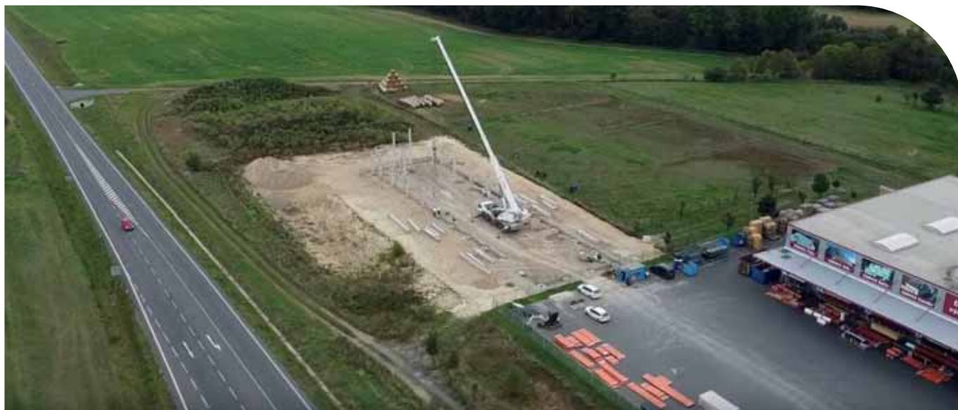
Září 2025: Zakládání pilotů pro železobetonovou konstrukci „stodoly“ v sousedství STŘECH COMAX
