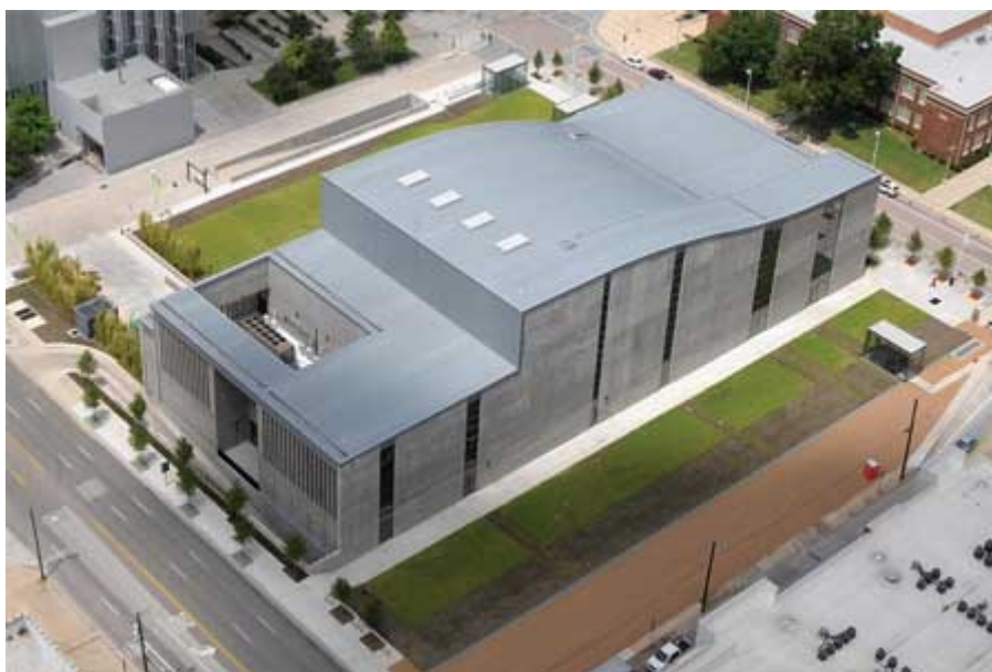
Obr. 2 Kulturní centrum v Dallasu, USA
