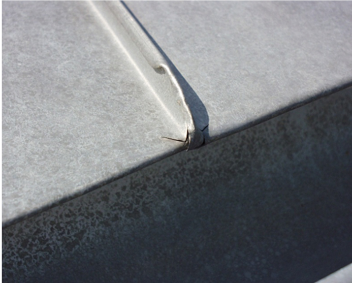
Obr. 4 Typické praskliny
